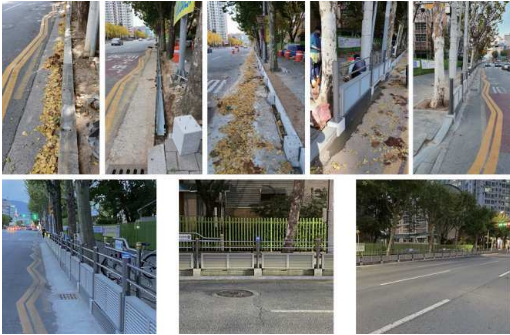
<그림 5-6> 제진벽 설치 과정
