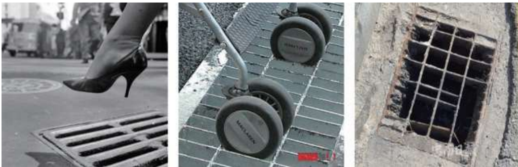
〈그림 2-3〉 기존 배수시설의 안전사고 예
