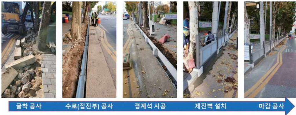
〈그림 3-3〉 도로 날림먼지 자동포집 시스템 시공 현장
