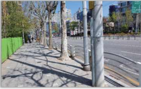
보행자펜스 (설치 전)
